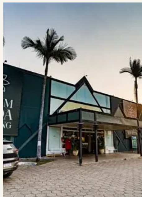
Foto: Fachada do Jardim Moda Shopping
